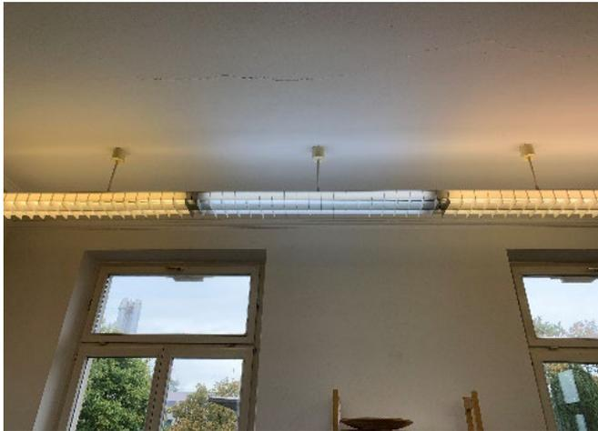
Bitte beachten Sie, dass die Leuchtstoffröhren die gleiche Farbtemperatur aufweisen, damit der Raum gleichmäßig beleuchtet werden kann.
