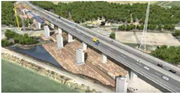
Abbildung 41: Ausschnitt aus Animationsfilm zum Bauablauf des Neubaus der Lennetalbrücke (Straßen.NRW, abrufbar unter https://www.strassen.nrw.de/projekte/a45/neubau-der-lennetalbruecke.html )
